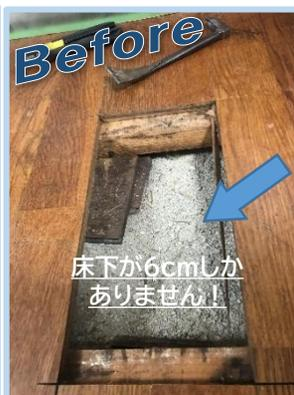
リビングの床が一部抜けそうになっているとの事で床を一部開口し、床下の状況を確認すると床下が6cmしかありません！通常の木造住宅では、地面から上がってくる水蒸気等で床が腐食しないように床下を45cm程度、確保するのですが、たった6cmでは十分に換気できません。これが大きな原因です！壁も確認してみると、壁の下部が腐食していました。
